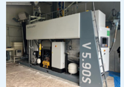
ブルクハルト社製 木質チップガス化熱電併給装置
