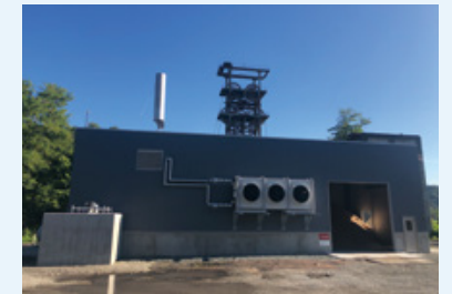
実証試験プラント
